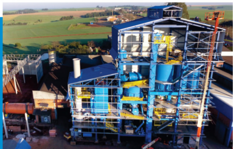
Preparação e Recuperação de Areia
