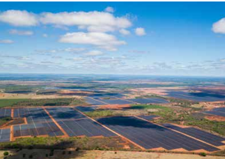
Complexo Solar Janaúba, em Minas Gerais (Imagem: Elera Renováveis - Divulgação)
