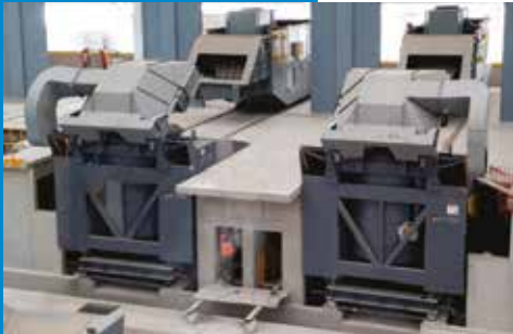
Carregamento de Forno com Exaustão
