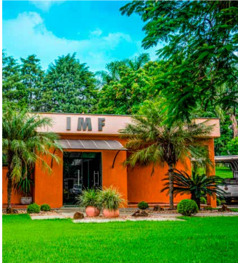
Fachada da Funperlita, localizada em Rio das Pedras (SP).
