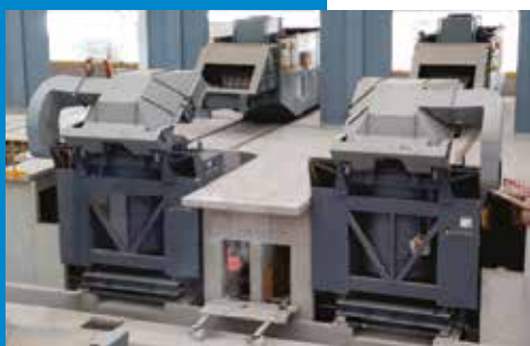
Carregamento de Forno com Exaustão
