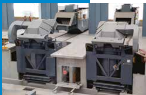
Carregamento de Forno com Exaustão
