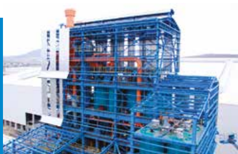
Preparação e Recuperação de Areia
