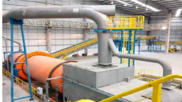
Figura 6 - Exemplos de enclausuramentos e captosres
