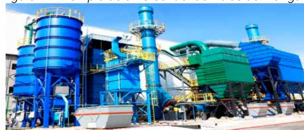
Figura 7 - Exemplo de uma central de filtros de mangas
