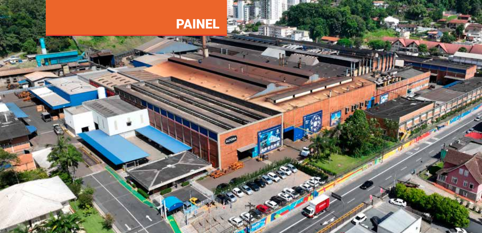
Fachada da sede da Altona, em Blumenau (SC).
