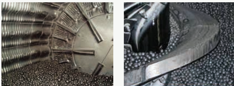
Figura 15: Aspecto geral das bolas de moinho e dos revestimentos em ferro fundido branco de alto cromo na parte interna de um moinho de bolas e de um moinho vertical.
