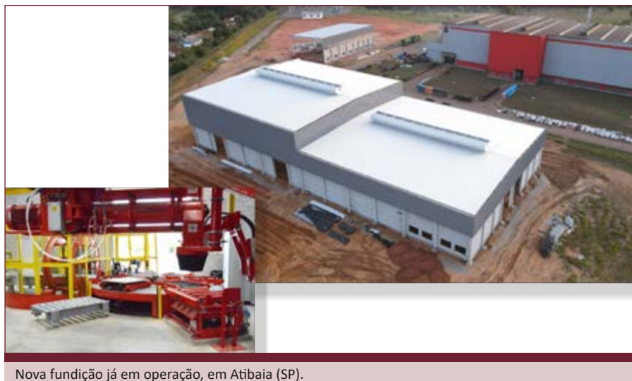
Nova fundição já em operação, em Atibaia (SP).
